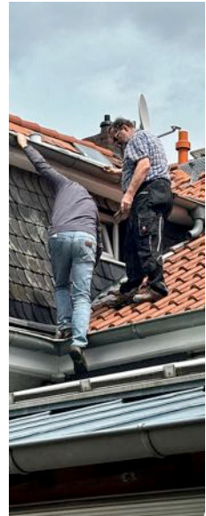
Dachprüfung am Gemeinde- haus
